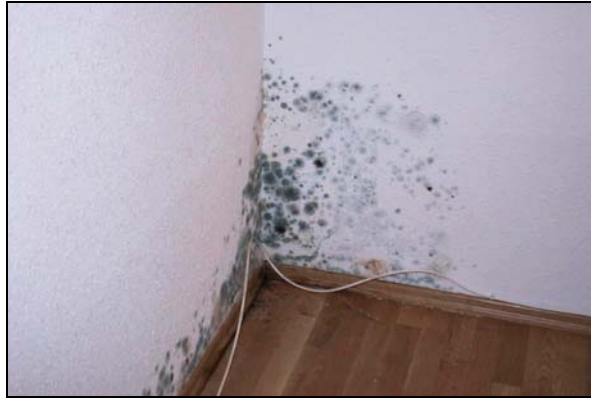
Abbildung 6: Schimmelbildung hinter einem Nachtkästchen
